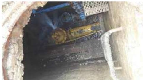
La vanne qui fuit est située sur la canalisation Acier DN 250 mm de refoulement (10 bars). Elle va des puits des Lacs et de la Grande Traverse vers la station de reprise de Bouyonnet.
