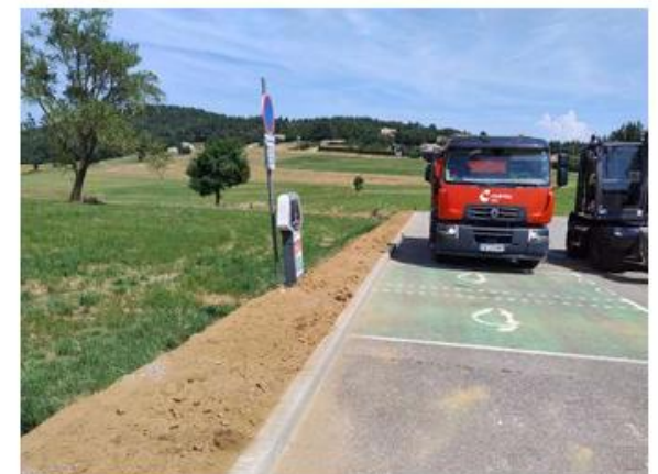
Côté Nord avec talus réglé
