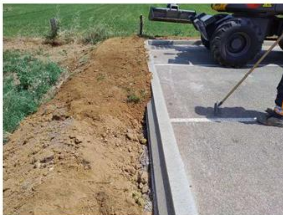
Côté Nord avec réglage du talus en cours
