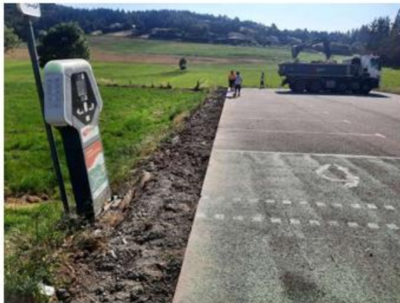
Côté Nord après découpe et évacuation des matériaux
